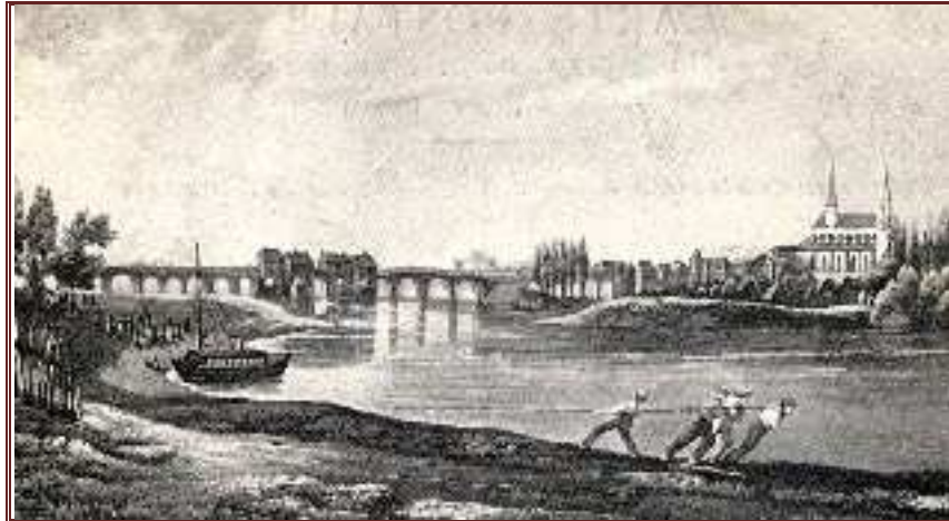
Tirage de la galiote depuis le pont de Poissy
