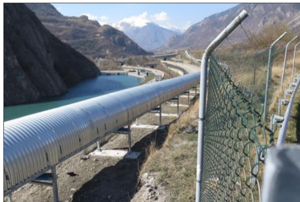
Sur l'ensemble du chantier, en France (ici à Saint-Martin-la-Porte) comme en Italie, des règles similaires s'appliquent. Photo Le DLF/T.
