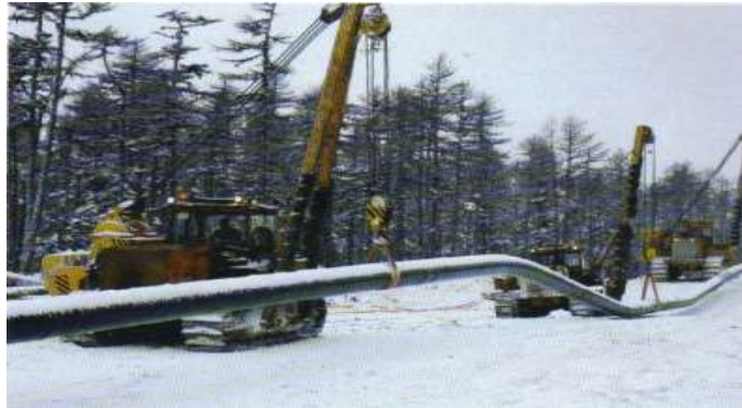
Pose d'une conduite d'hydrocarbure dans l'île de Sakhaline
