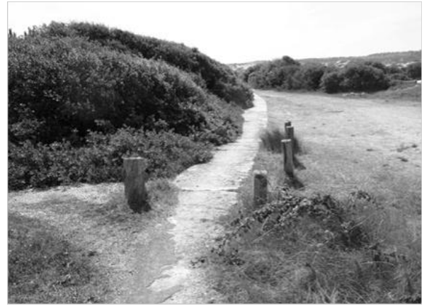
L'écartement et la régularité de la courbe de cette piste cyclable font penser à l'utilisation de la voie métrique pour en réaliser le coffrage
