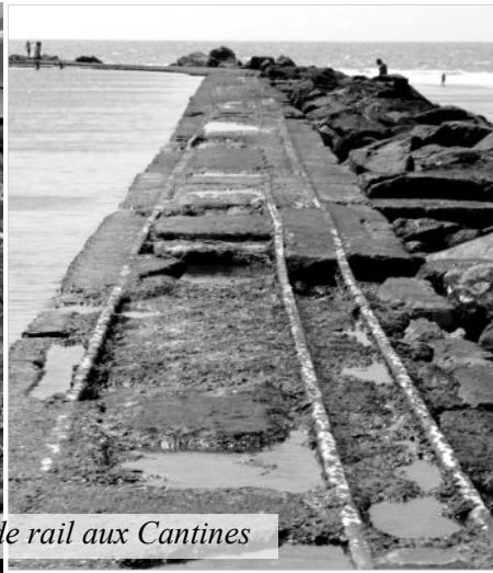
Le plateau des Cantines. A gauche, ancien poteau de repérage d'un épi et d'éclairage, constitué d'un coupon de rail double champignon symétrique
