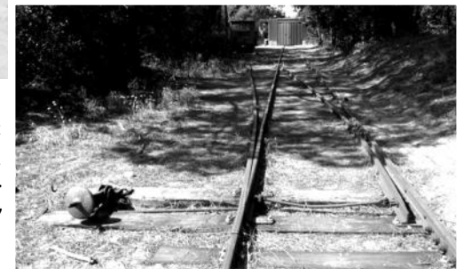
L'aiguille du dépôt et son levier "métrique"
