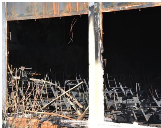
■ La salle de théâtre est complètement détruite. Photo Claude Essertel
