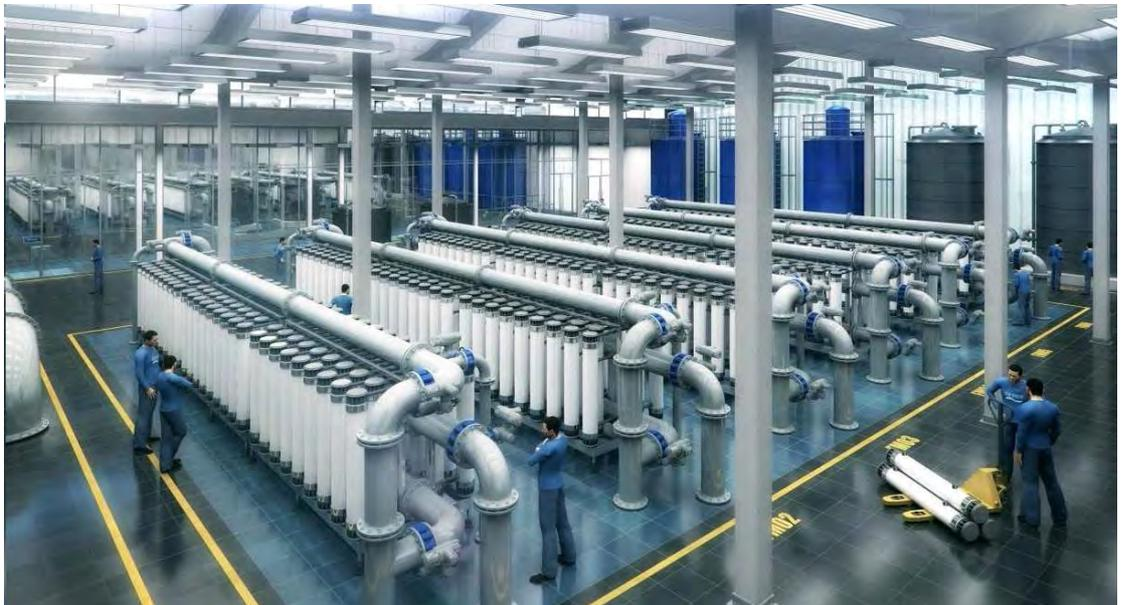
—Spiegelgleiche Anordnung der TWA mit der Membranfiltration
